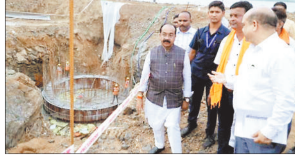
निर्माणधीन वॉटर ट्रीटमेंट प्लांट का निरीक्षण करते उप मुख्यमंत्री।
